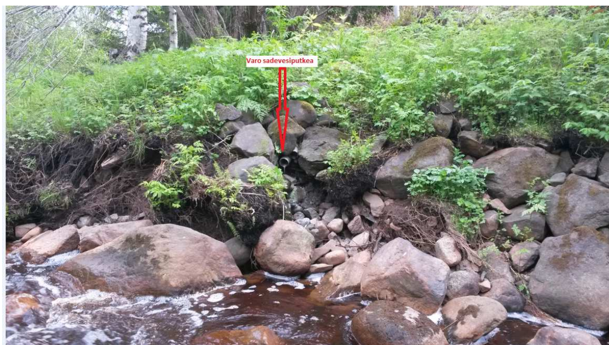
Kuva 5. Kohdenumero 1 (Sadevesiputki 4m kohdalla)
