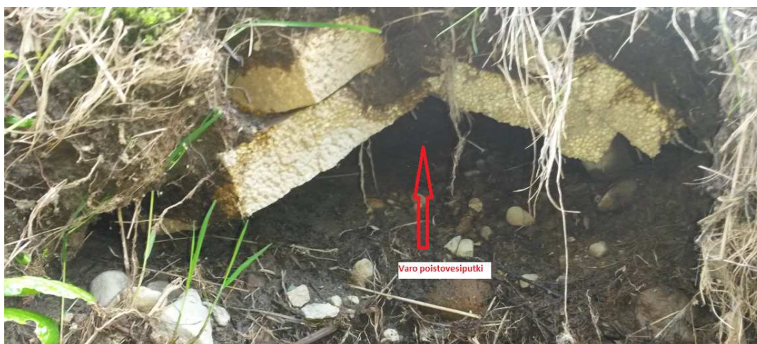
Kuva 11. Kohdenumero 4 (poistovesiputki 36m kohdalla)
