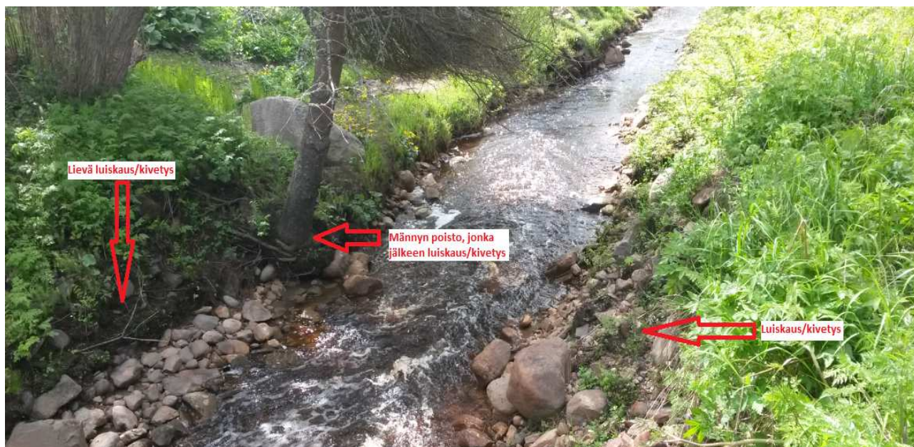
Kuva 6. Kohdenumero 2 (männyn poisto 16m kohdalla)
